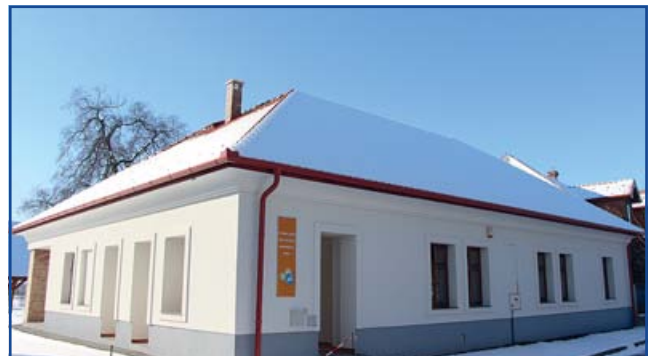
A Kereskedelmi Szolgáltató és Információs Pont épülete az utca felől...
